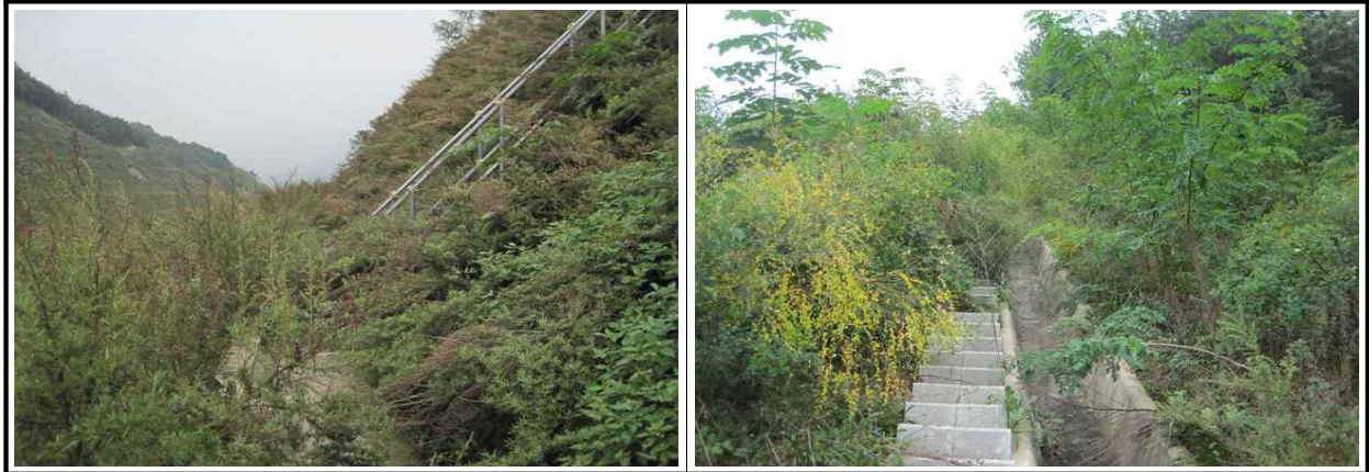
【그림 12.3.3】 배수시설 전경
